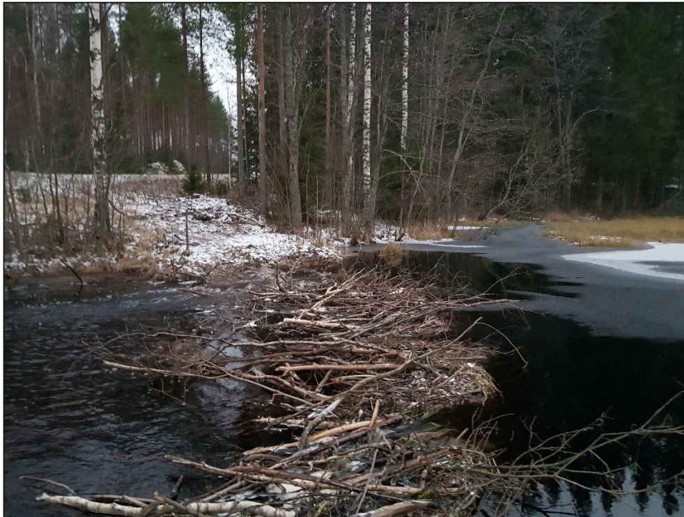
Kuva 5. Pukkielällä oleva nykyinen patorakenne.
